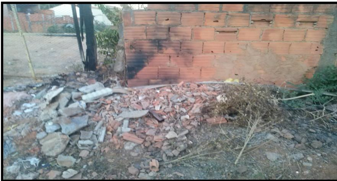
Figura 01: Acúmulo de lixo na Rua Quincas Souto, Vila Atlântida, Montes Claros/MG.
