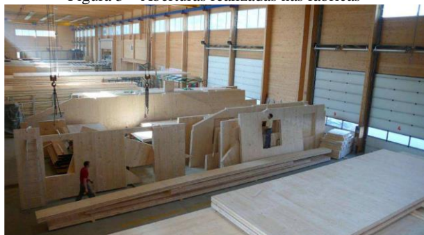
Figura 3 – Aberturas realizadas nas fábricas
