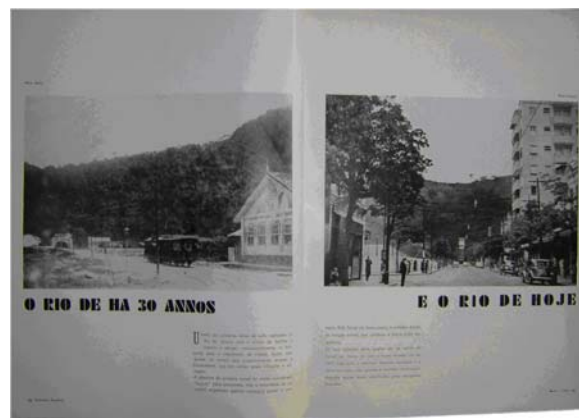
FIGURA 2: Dois aspectos do “Túnel do Leme”, no Rio de Janeiro: um em 1903 e outro em 1941, publicados na seção O Rio de hoje e de há 30 anos da edição n. 71, março de 1941, da revista Ilustração Brasileira . Segundo o texto que acompanhava a fotografia, as “humildes construções” foram substituídas pelos “arrogantes fura-céus”.
