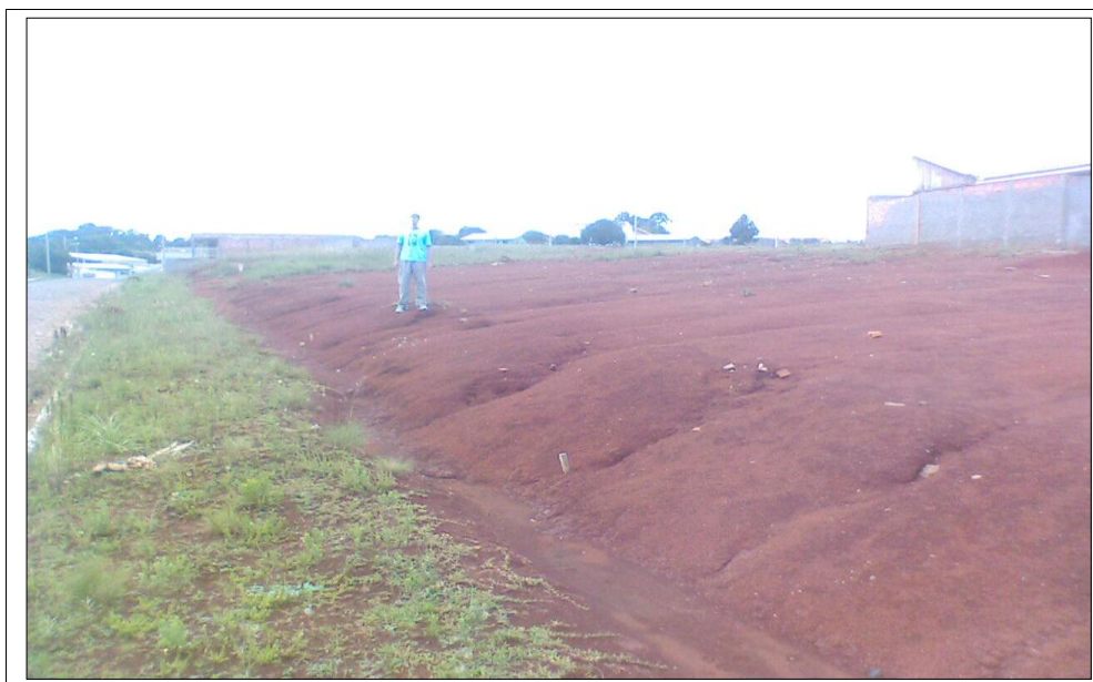
FIGURA 7. Vista geral de ravinas formadas no depósito de material espólico da Rua Jaú; Fonte: Pereira (2009)
