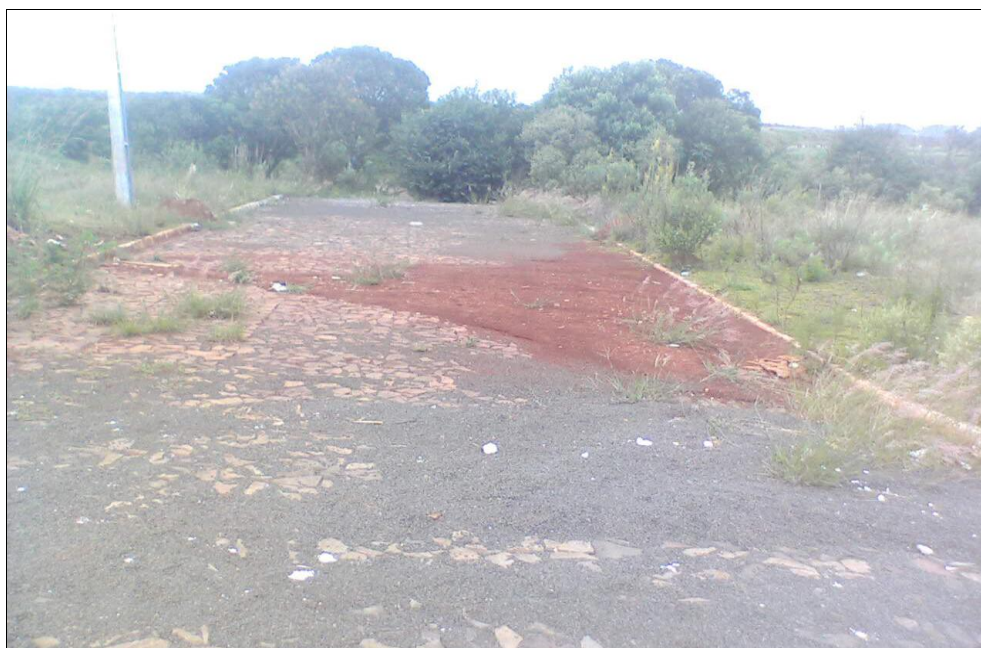
FIGURA 8 Cone de dejeção de sedimentos provindo do depósito de material espólico da Rua Jaú Fonte: Pereira (2009)
